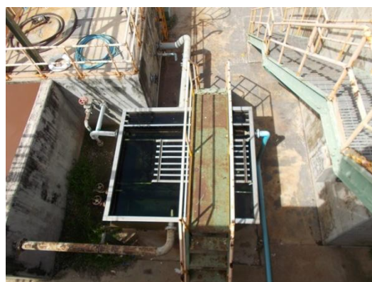
รูปที่ 3-11 Oil Separation System
