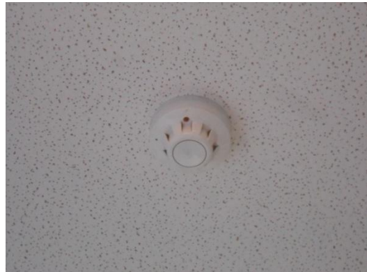
รูปที่ 3-40 Smoke Detector
