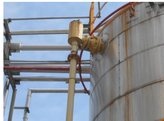
รูปที่ 3-50 Fixed Foam Spray System
