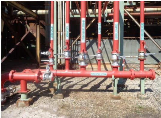
รูปที่ 3-45 Fixed Water Suppression System
