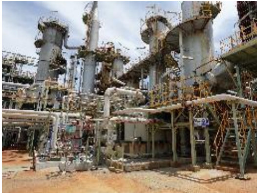
รูปที่ 3-6 Double-Contact/Double Absorption เพื่อบำบัด SO 2 และ Acid Mist
