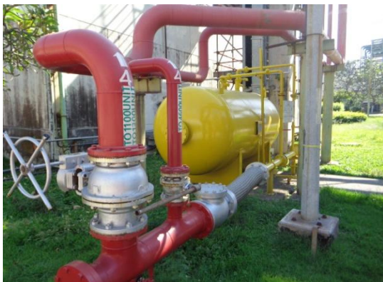
รูปที่ 3-49 Fixed Foam Discharge Outlet
