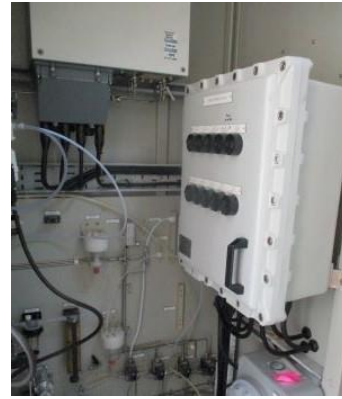
รูปที่ 3-2 เครื่องตรวจวัดความเข้มข้นของมลพิษ ทางอากาศอย่างต่อเนื่อง (CEMS)
