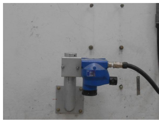
รูปที่ 3-38 Gas Detector
