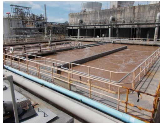
รูปที่ 3-13 Activated Sludge System
