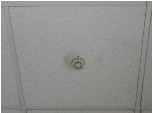
รูปที่ 3-39 Heat Detector
