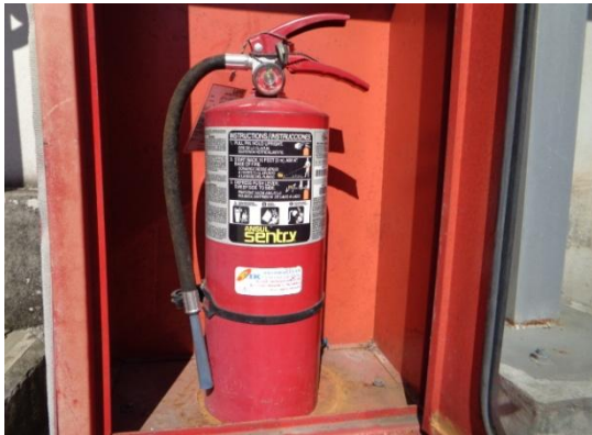
รูปที่ 3-51 Portable Fire Extinguisher
