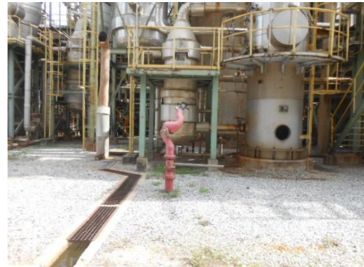
รูปที่ 3-46 Fixed Water Monitor
